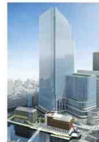
日本橋一丁目中地区再開発事業 (2026年竣工予定)
