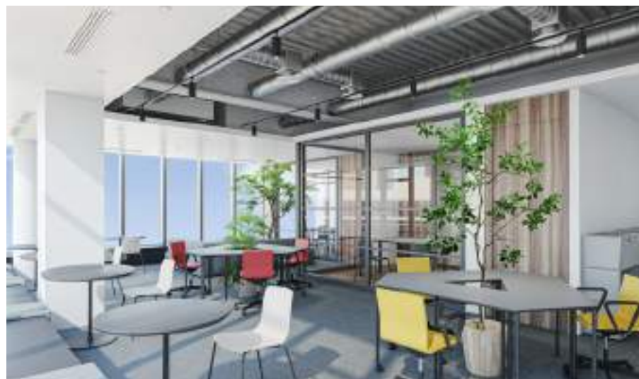
※空調用ダクトはフレキシブルダクトを採用
