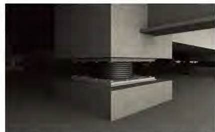
天然ゴム系積層ゴム(NRB) Natural rubber bearing
